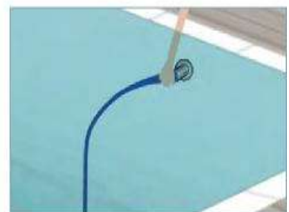
Mettre en place et nettoyer via la prise balai, si nécessaire en envoyant directement à la vidange les poussières les plus fines (vanne 6 voies en position vidange)
